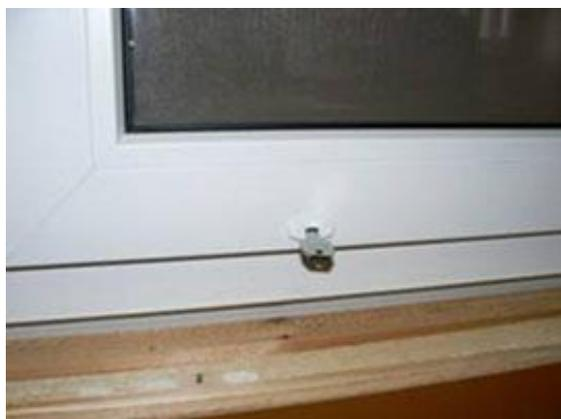
**Внутренний стальной блокиратор,** позволяющий фурнитуре свободно открываться в поворотно-откидном положении и только на 10-15 см в поворотном. Это устройство не видно снаружи окна, оно полностью сделано из стали, устанавливается в верхней части окна. Чтобы открыть створку полностью необходимо разблокировать устройство, на это затрачивается около 1 минуты времени. Ребенок до 6 лет снять блокиратор не сможет, если Вы не будете делать операцию в его присутствии
